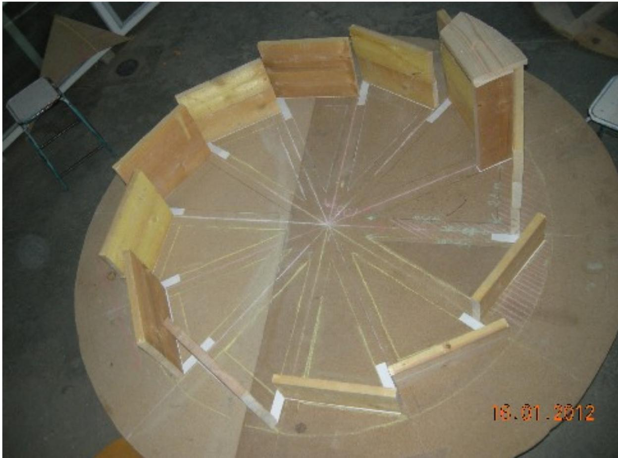
(La roue) Partie du composteur en béton armé,
