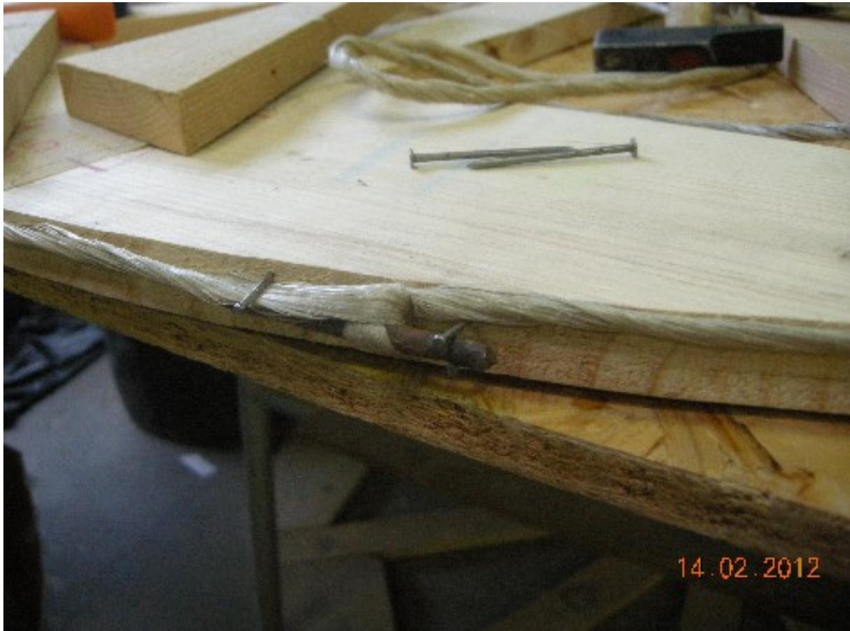
L'assemblage des deux roues par les 12 liteaux qui servent de butée aux 12 portes + le poteau central, qui cloisonne les tiroirs.
